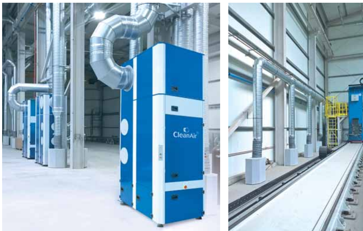
▼ Instalacja systemu PUSH-PULL ▼
